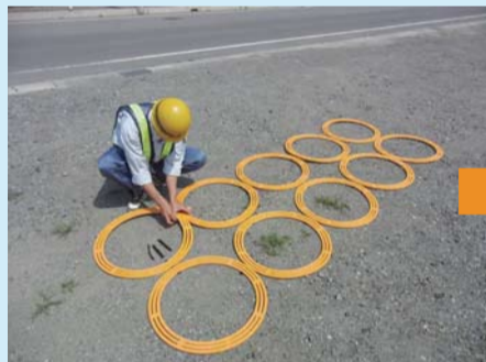
広いスペースで前もって組立を行います
