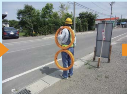
「8」の字形状に折り畳み、設置ポイントまで運びます
